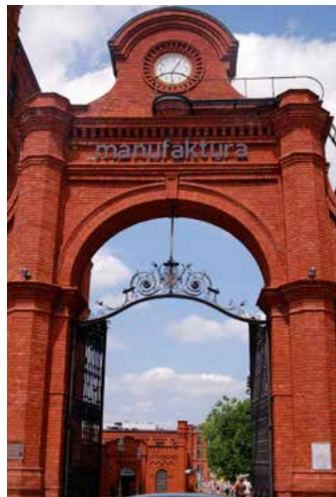
由旧厂区改造成的Manufaktura购物中心， 图为购物中心大门
